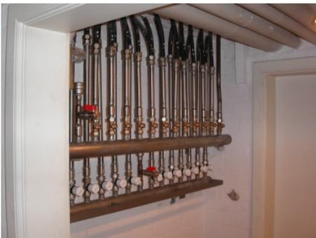
Zum Abschluss der Arbeiten werden die Verteiler gespült, die Heizungsanlage wieder befüllt und entlüftet.
