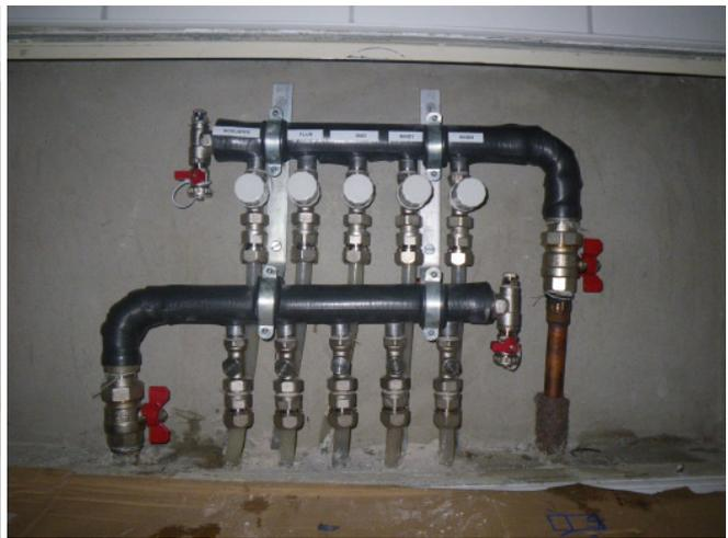
Neue Maßanfertigung eines Heizkreisverteilers aus Edelstahl, die Kunststoffrohre ragen am Rücklauf nur 50mm aus dem Putz, auch das Hauptventil sitzt bündig auf der Putzoberfläche. Hier muss eine Maßanfertigung zum Einsatz kommen.
