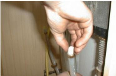
Nach dem Leeren der Heizkreise werden die Projektilen in die Rohre geschoben und per Luftdruck mehrmals durch die Leitung geschossen.
